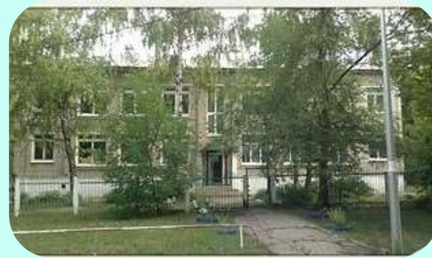
2 корпус ул. Дзержинского, 18 10 групп
